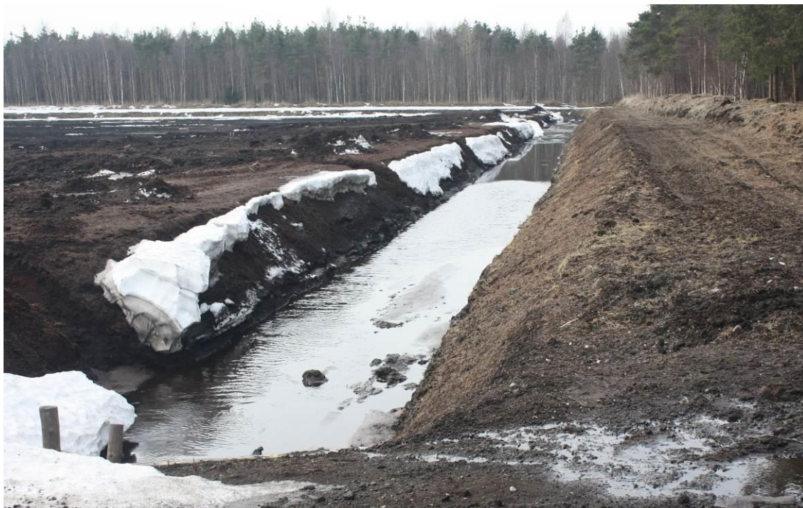
Pilt 5.1 Kuivenduskraavi suubumine kogujakraavi
